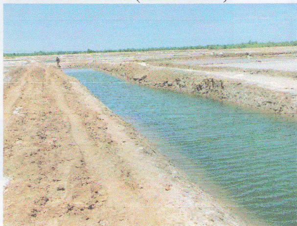
Le bassin de réserve (condensateur)
