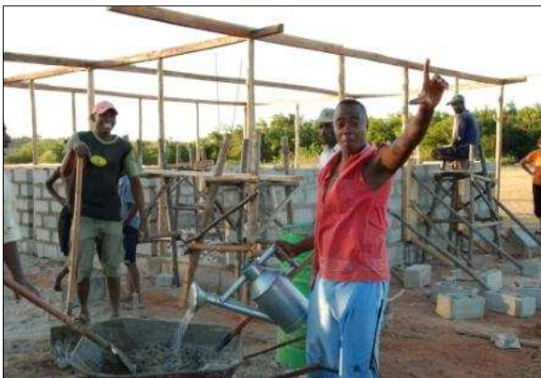
Les villageois construisent l'école.
